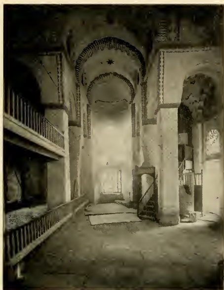
Fig. 461 — Interno della chiesa del convento di Myrelaion a Costantinopoli (a. 918)
